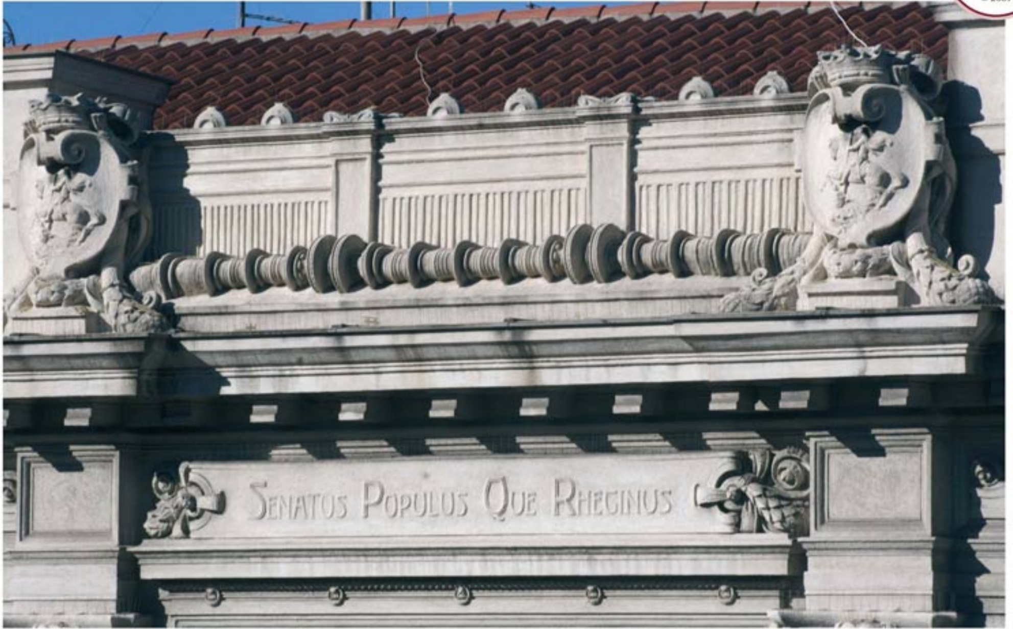
stemmi sul frontone del Palazzo Comunale, lato Corso Garibaldi
